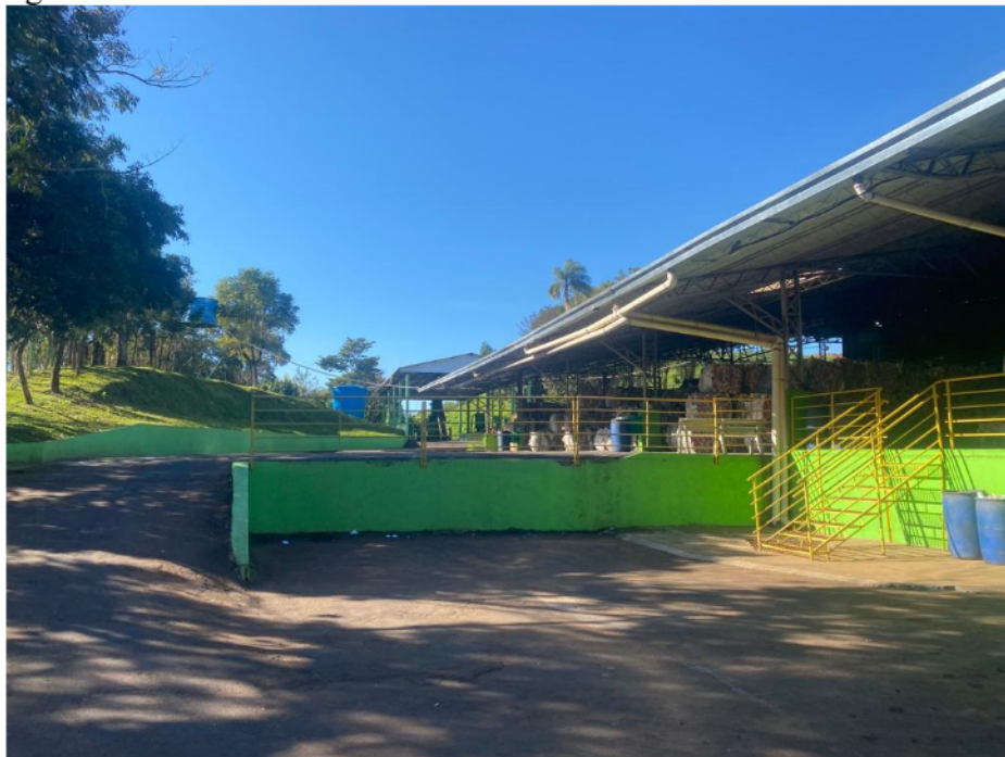
Figura 18: Vias do consórcio com massa asfáltica.
