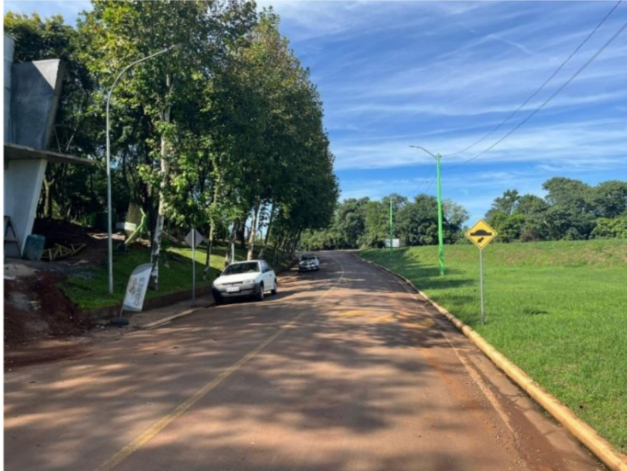
Figura 17: Via de acesso principal.
