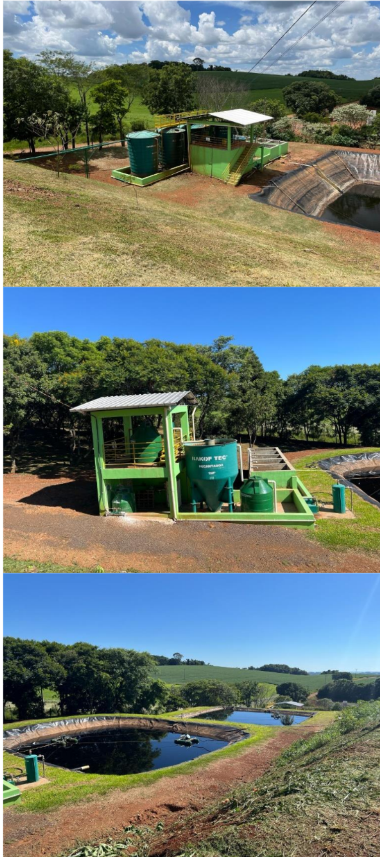
Figura 34: Estação de tratamento do efluente/lixiviado.
