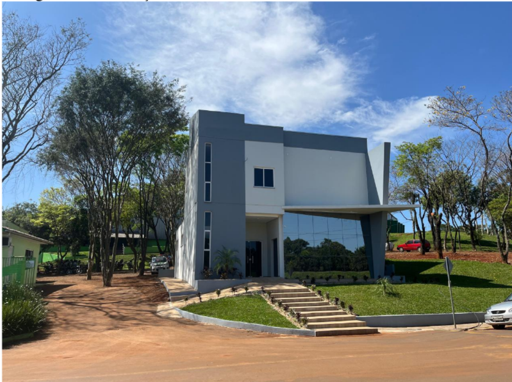
Figura 24: Construção do auditório e escritório.
