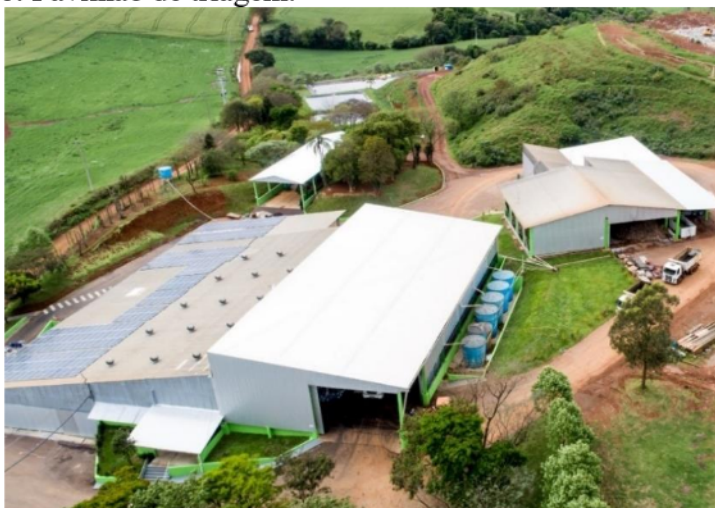
Figura 26: Pavilhão de triagem.
