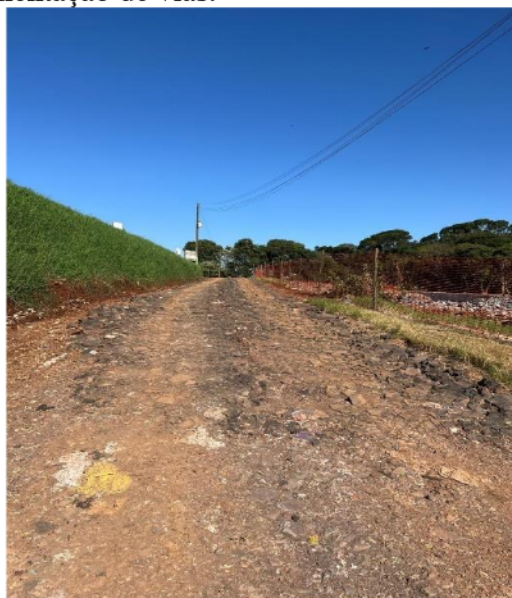
Figura 48: Pavimentação de vias.
